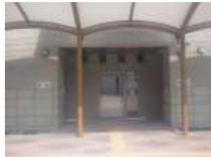
東口駐車場付近のトイレ 駐輪場やベンチ、タクシー乗り場 等、付近はきれいに整備されてい ます
