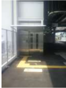
下り線ホームのエレ ベーター
